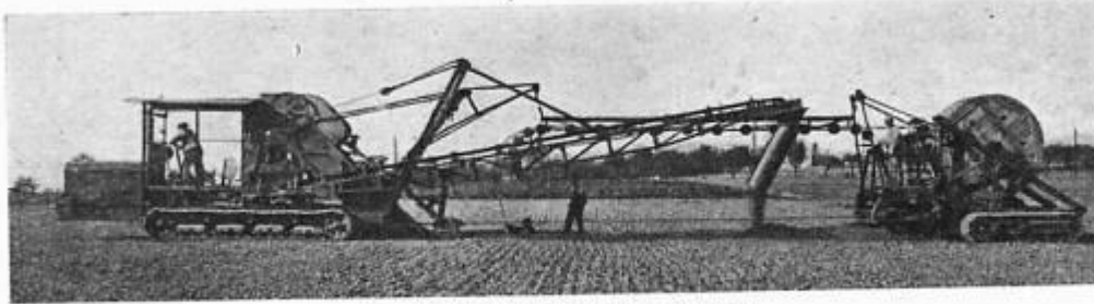
FIG. 78. MACHINE LAYING OF CABLES (Wasserhülle A.-G.)
